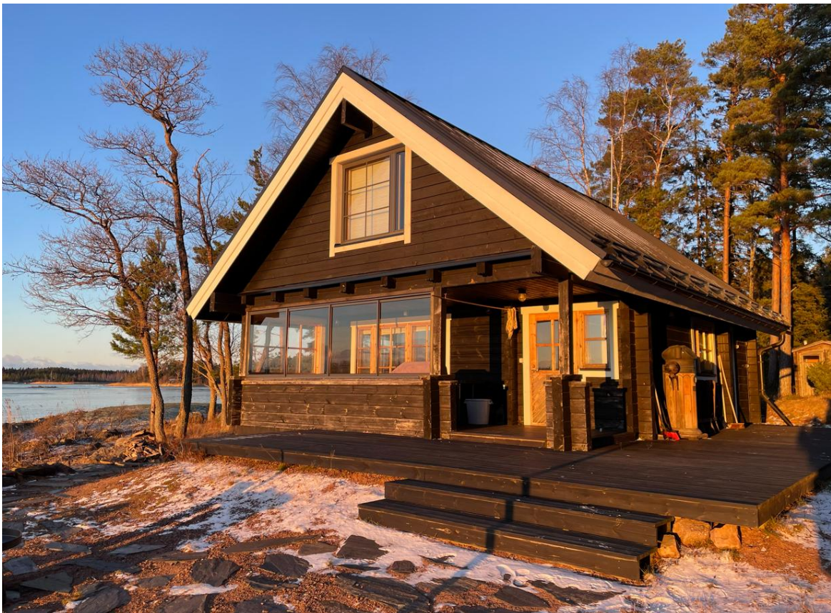
Keskimmäisellä kiinteistöllä on (442-407-5-229) 1986 valmistunut saunarakennus, joka on kooltaan 44 m 2 .
