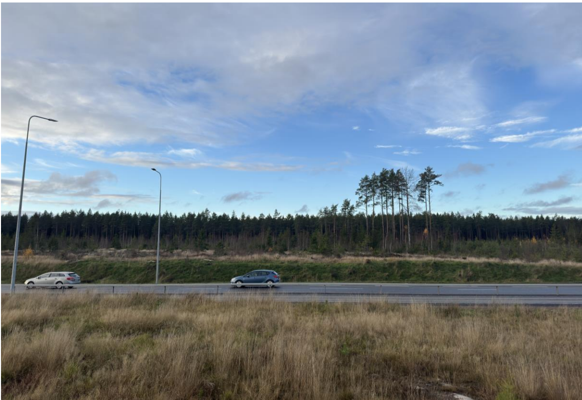
Kuva 5 Näkymä selvitysalueen kaakkoispuolelta yli Porintien ja Raumantien selvitysalueelle, jossa on laaja hakkuuaukea (kuvauspiste 3).
