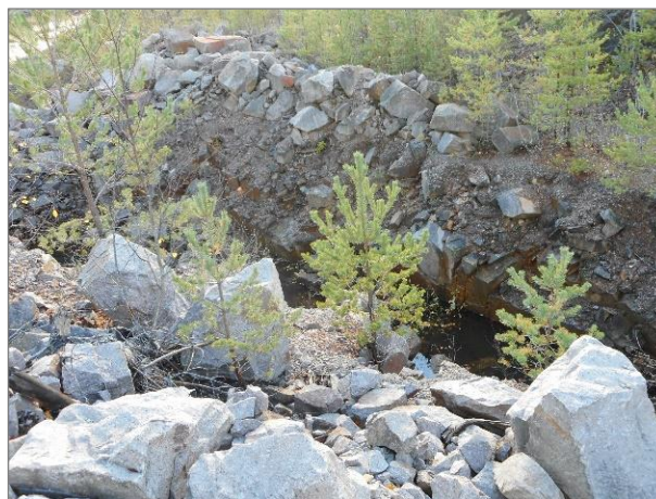
Kuva 29. Louhittu oja, jota pitkin vedet valuvat pois hankealueelta.
