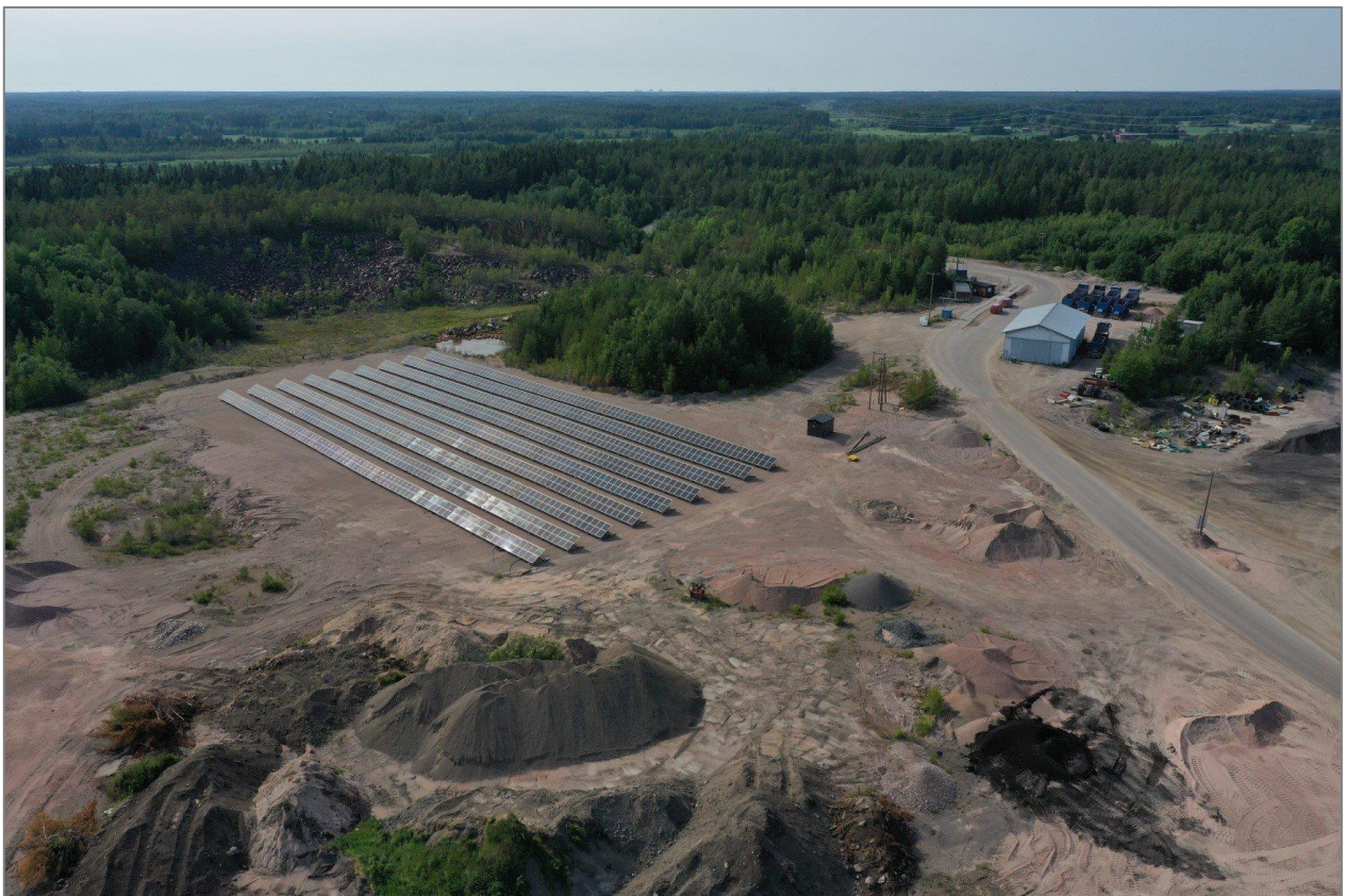
Kuva 13. Noin puolet hankevastaavan murskaamon sähköntuotannosta saadaan alueella olevista aurinkopaneeleista. (Kuvan lähde: Hankevastaavan kotisivut.)
