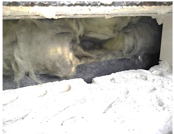
Kuva rakenne kuiva, villa vasten ulkokuoren tiiltä
