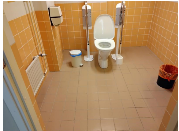
Kuva aulan inva WC-tila, lattialaatat kopona
