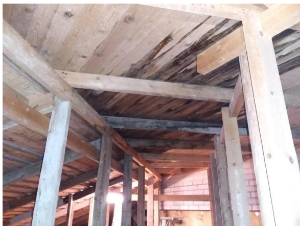
Kohta 6, marinetin juuri tiivistettävä (laudoituksesta ei nyt tippunut vettä). Takimmaisesta marinetista puuttuu hattu (vesi pääsee suoraan yläpohjaan).
