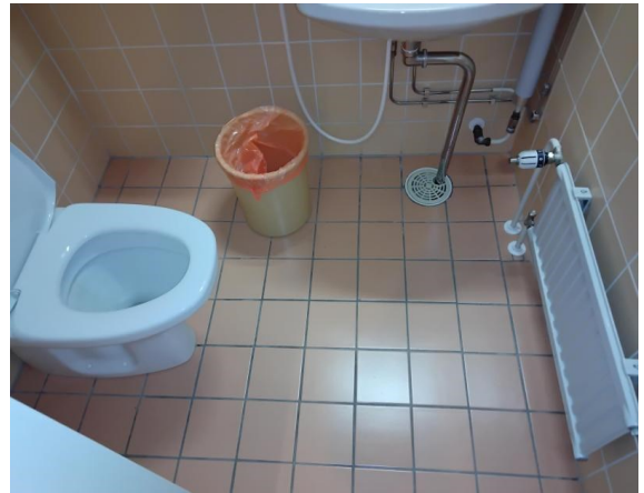
Kuva wc-tilan 329 lattialaatoitusta kopona
