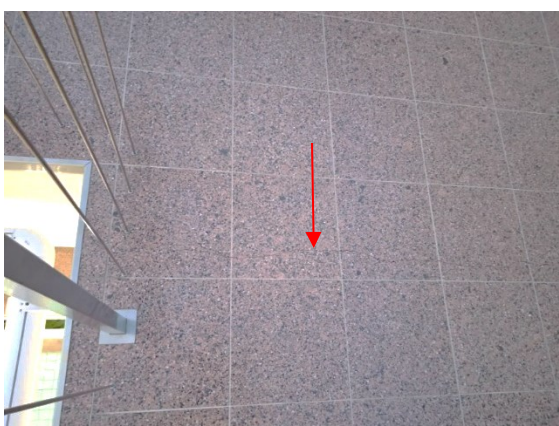
Kuva laatassa halkeama
