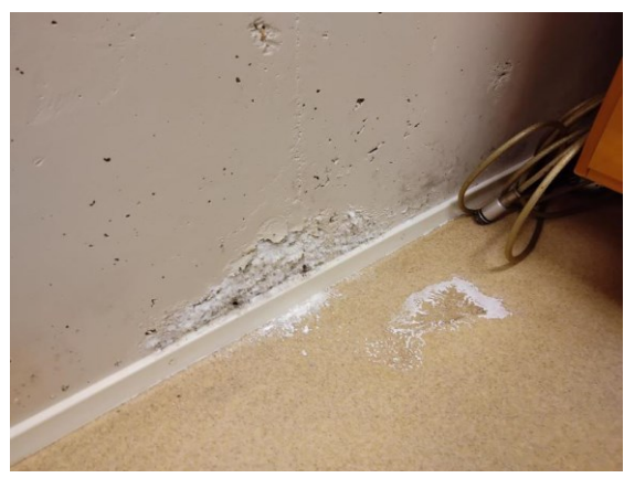
Kuva nro seinän alaosassa kalkkihärmää
