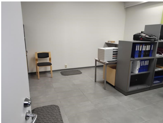
Kuva tilassa 111 muovimattopinnoite on vaihdettu laattapinnotteeseen
