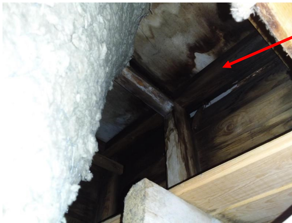
Vuotokohta 5, ilmastointiputkien läpivientikohdat vuotavat. Läpivientikotelon pellityksen päällä makaa vesi.
