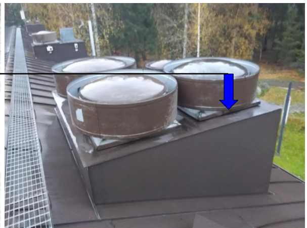
Vuotokohta 3, ilmastointiputkien läpivientikohdat vuotavat. Läpivientikotelon pellityksen päällä makaa vesi.
