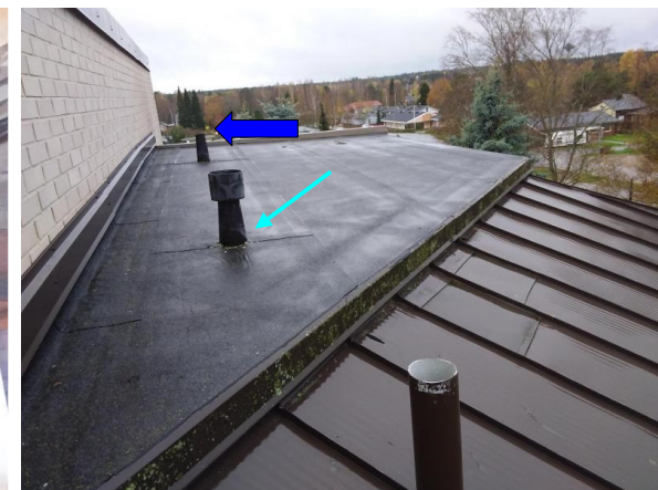
Kohta 6, marinetin juuri tiivistettävä (laudoituksesta ei nyt tippunut vettä). Takimmaisesta marinetista puuttuu hattu (vesi pääsee suoraan yläpohjaan).
