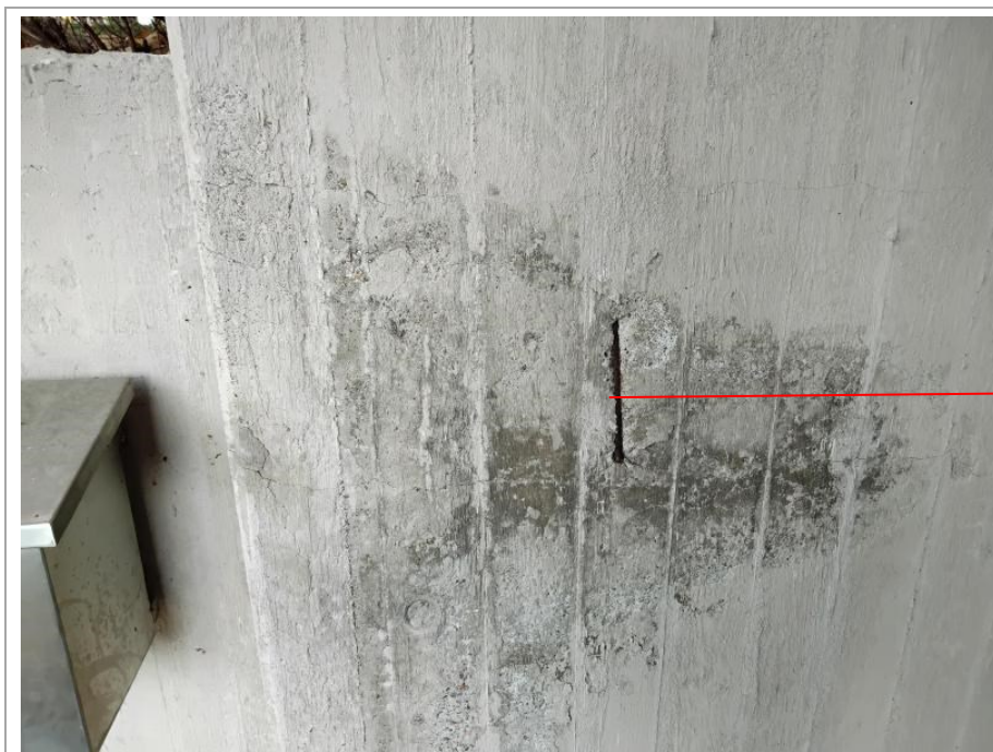
Raudoituksien päältä rapistunut betonipeite
