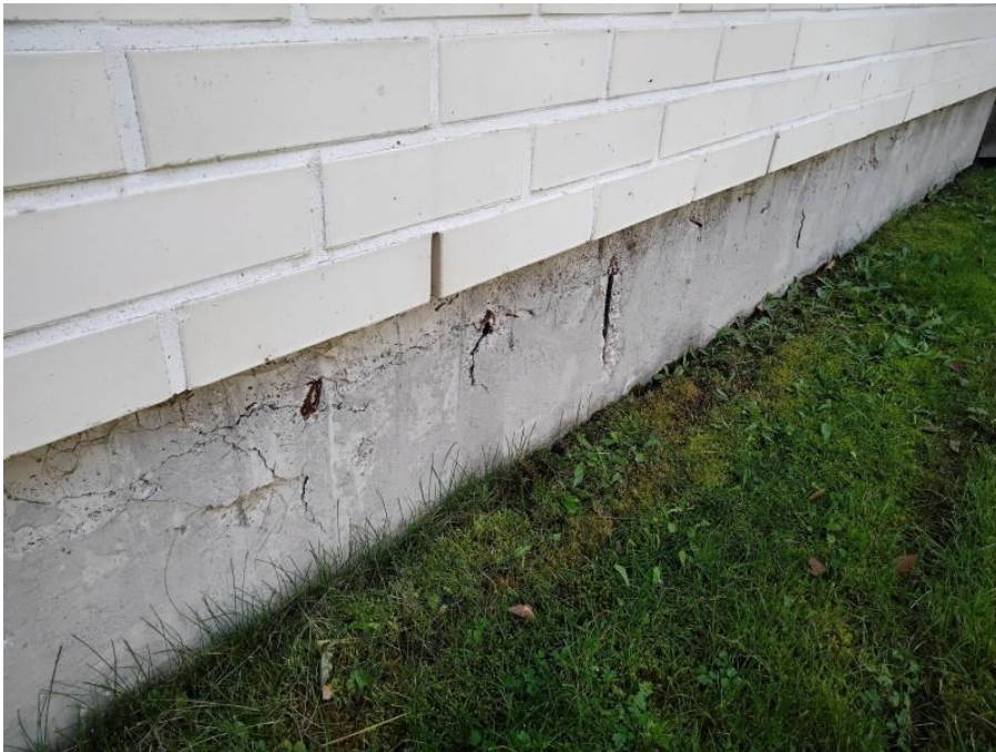
Sisäpihalla raudoituksia näkyvillä
