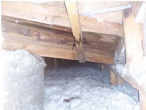
Kohta 2, sisäjiirin pellityksen saumakohdat tarkistettava.
