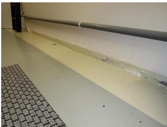
Kuva maanpaineen vastaisen maalipinnoite kupruilee, pinnoilla kalkkihärmää
