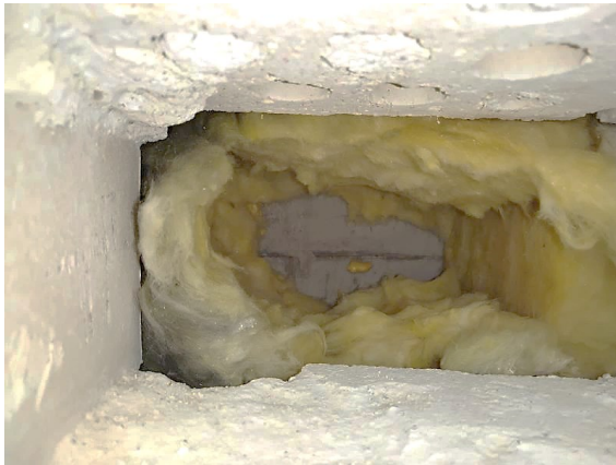
Kuva sisäkuoren betoni kuiva
