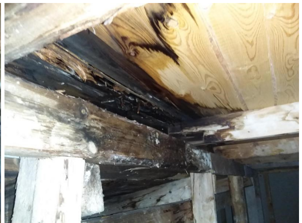
Vuotokohta 3, ilmastointiputkien läpivientikohdat vuotavat. Läpivientikotelon pellityksen päällä makaa vesi.
