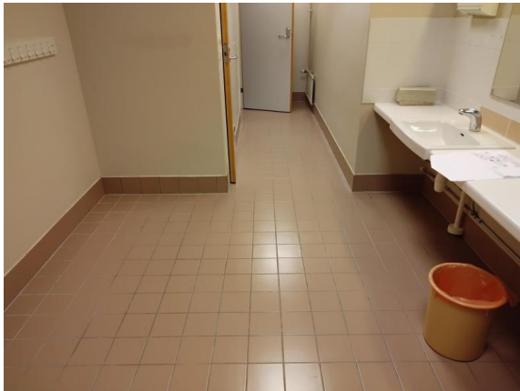
Kuva wc-tila 120 lattialaatat kopona
