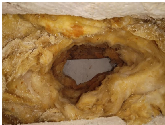
Kuva betonipinta märkä
