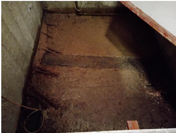
Kuva pakotunnelissa irtokosteutta
