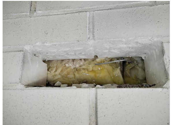
Kuva rakenne kuiva, villa vasten ulkokuoren tiiltä
