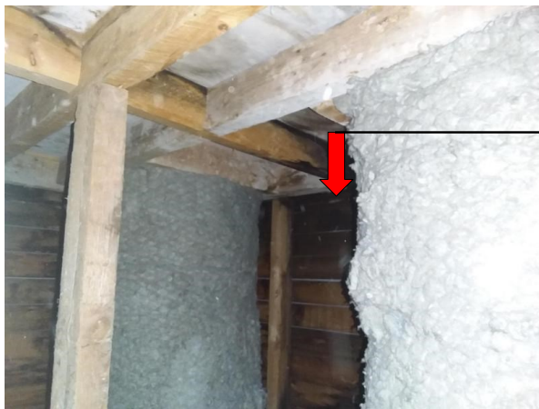
Vuotokohta 3, ilmastointiputkien läpivientikohdat vuotavat. Läpivientikotelon pellityksen päällä makaa vesi.
