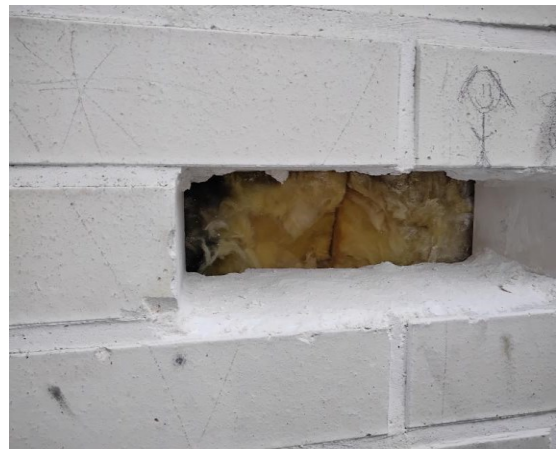
Kuva rakenne kuiva, villa vasten ulkokuoren tiiltä
