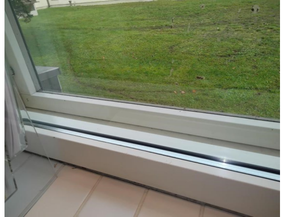
Kuva huonetilan 248 ikkunarakenne, ei vaurioita, ikkuna pohjoiseen päin
