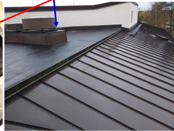
Vuotokohta 5, ilmastointiputkien läpivientikohdat vuotavat. Läpivientikotelon pellityksen päällä makaa vesi.
