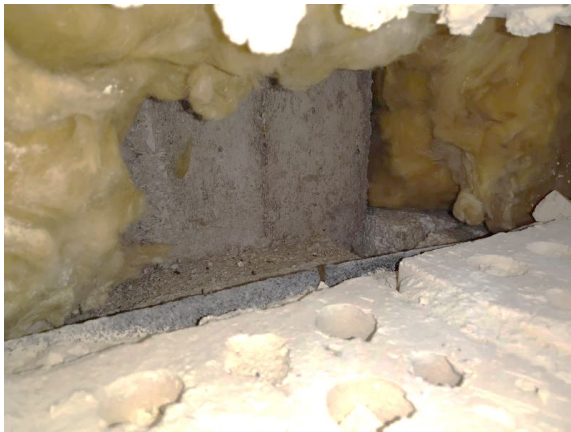
Kuva sisäkuoren betoni kuiva
