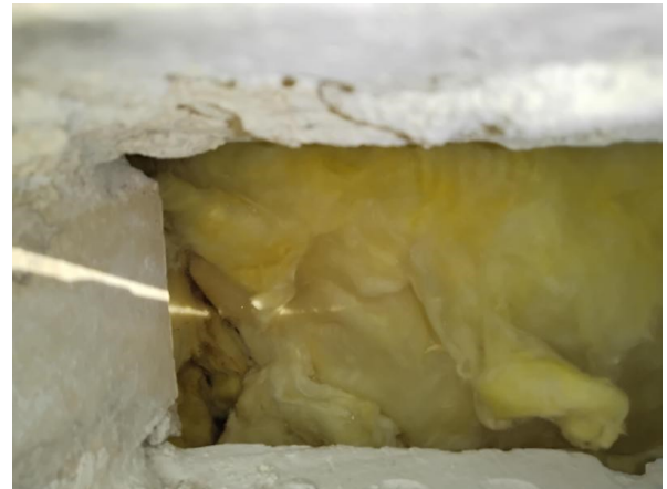
Kuva nro rakenne kuiva, villa vasten ulkokuoren tiiltä
